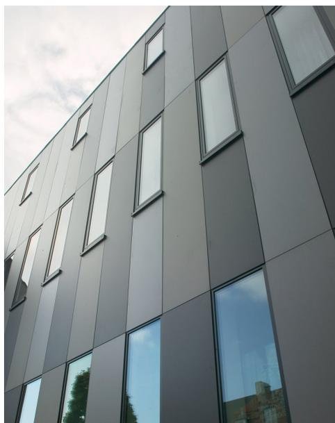
Proposé par ABET LAMINATI (print), le **MEG** est un stratifié haute pression (HPL) autoportant avec une surface décorative prévue pour une exposition à un environnement extérieur, résistante à la lumière et aux intempéries, et répondant à la norme EN 438-6 : 2005. Il se compose de couches de fibres cellulósiques imprégnées de résines phénoliques et, en surface, d'une ou plusieurs couches de fibres cellulósiques à fonction esthétique, imprégnées de résines thermodurcissables.
